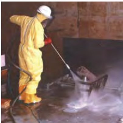
Υδροβολή - Υδροκοπή Waterblasting - Water jet cutting
